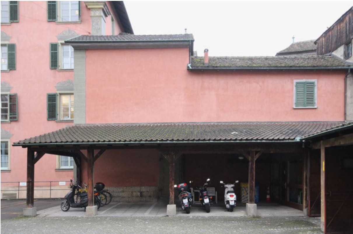
Diese Seite: Das alte Stadthaus vor dem Umbau. Ein Teil des von 1886 stammenden Archivanbaus wurde abgebrochen. Rechte Seite: Heute verbindet der Neubau an dieser Stelle die Gebäude.
